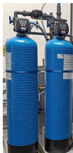
Doppelenthärtungsanlage
